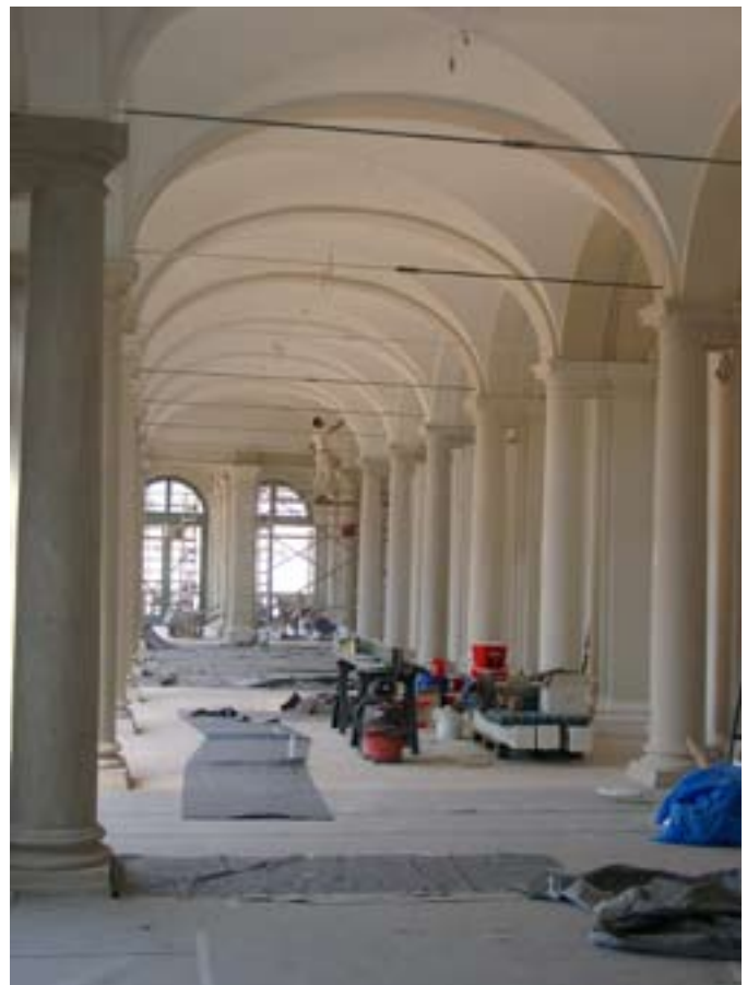
Während der Bauarbeiten für die neue Ostasien-Galerie, Zwinger
